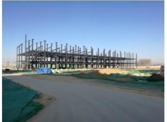
在建生产车间
