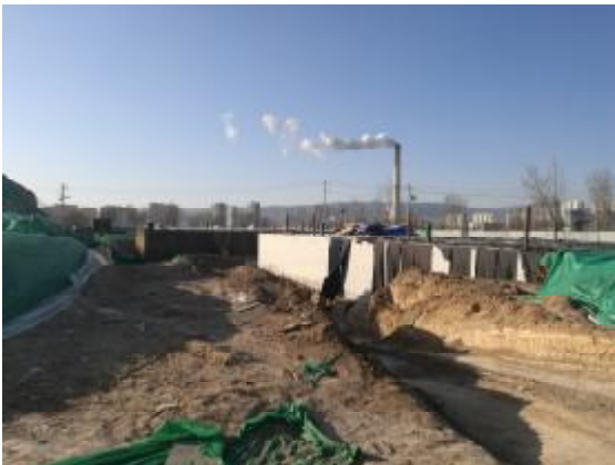
在建初期雨水池和消防水池
